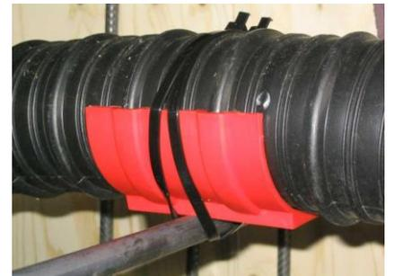
Bild 5: Spanngliedunterstützung mit Schutzschale
