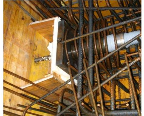
Bild 2: versetzte Ankerplatten
