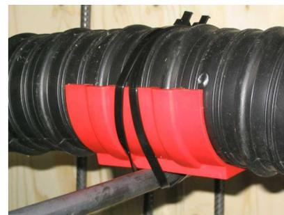
Bild 5: Spanngliedunterstützung mit Schutzschale
