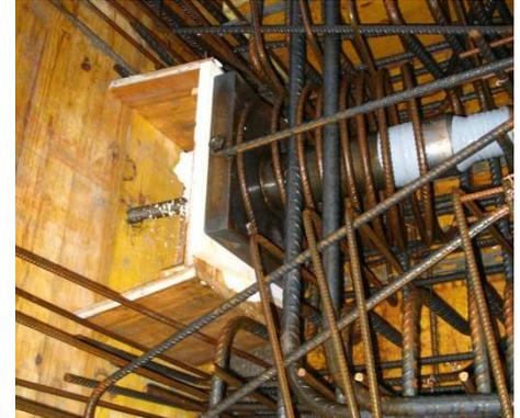
Bild 2: Versetzte Ankerplatten
