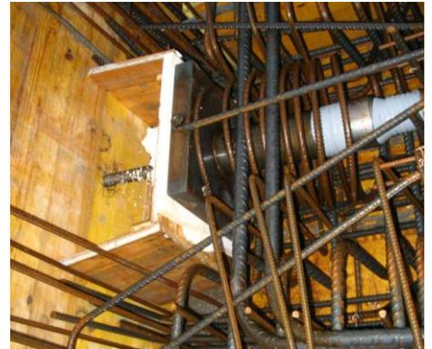
Figure 2: Plaques d'ancrage posées
